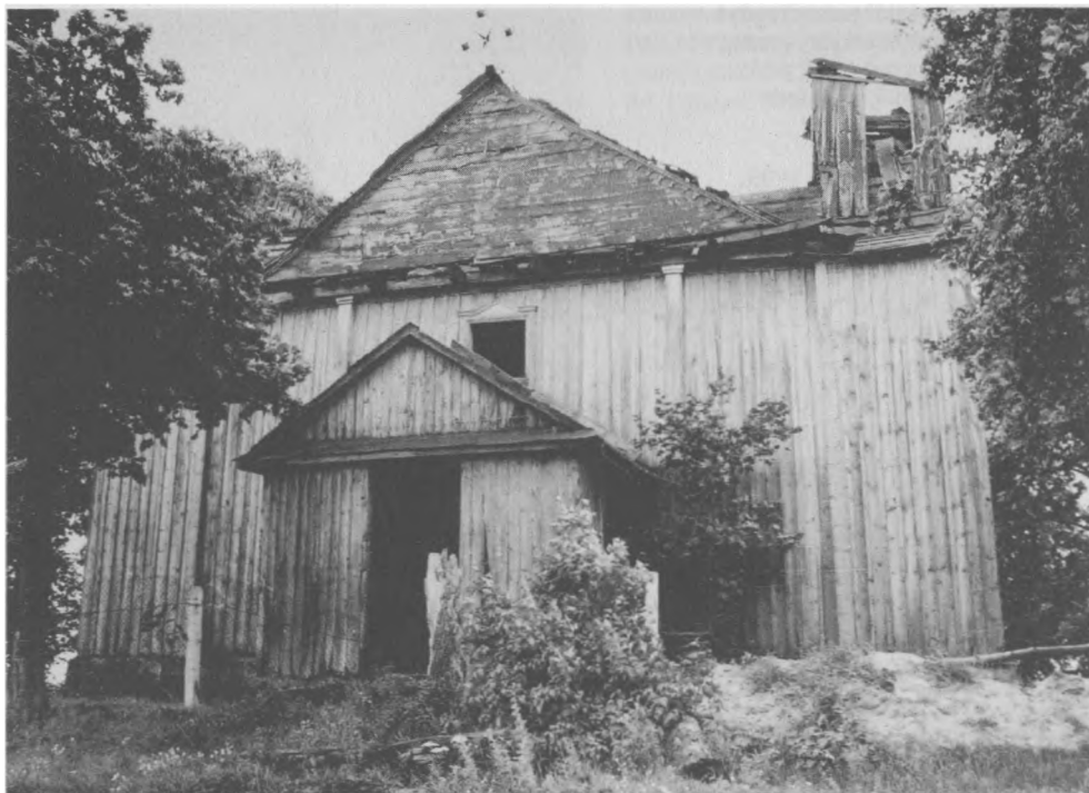
Wiszenki, kościół par., elewacja frontowa; stan przed przeniesieniem do Kowla (Aneks poz. 1.1.19); fot. Ryszard Brykowski, 1993
