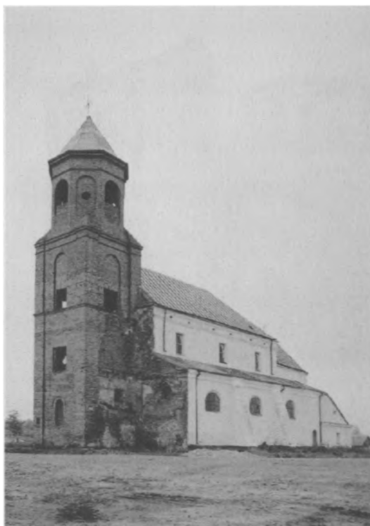
Zaturce, kościół par.; widok od pd.-zach.; stan zewnętrzny po odzyskaniu 1992 (Aneks poz. 1.1.21.); fot. Ryszard Brykowski, 1993
