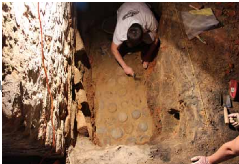
Drobin, dwór. Pomieszczenie 5 – izolacja z kafli garnczkowych.
