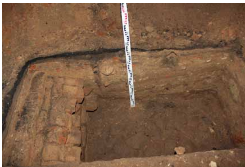
Drobin, dwór. Pomieszczenie 5 – fundament ściany NS pierwotnego podziału piwnic z widocznym wyjściem sklepienia i posadzką z bruku kamiennego.
