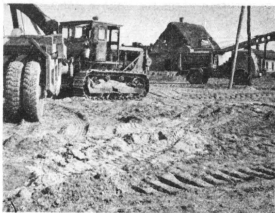
Przy budowie kombinatu stare ustępuje miejsca nowemu
