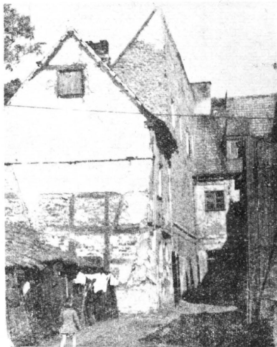
Takie domy „zagrożone” — liczące łącznie do 1000 izb ulegną rozbiórce
