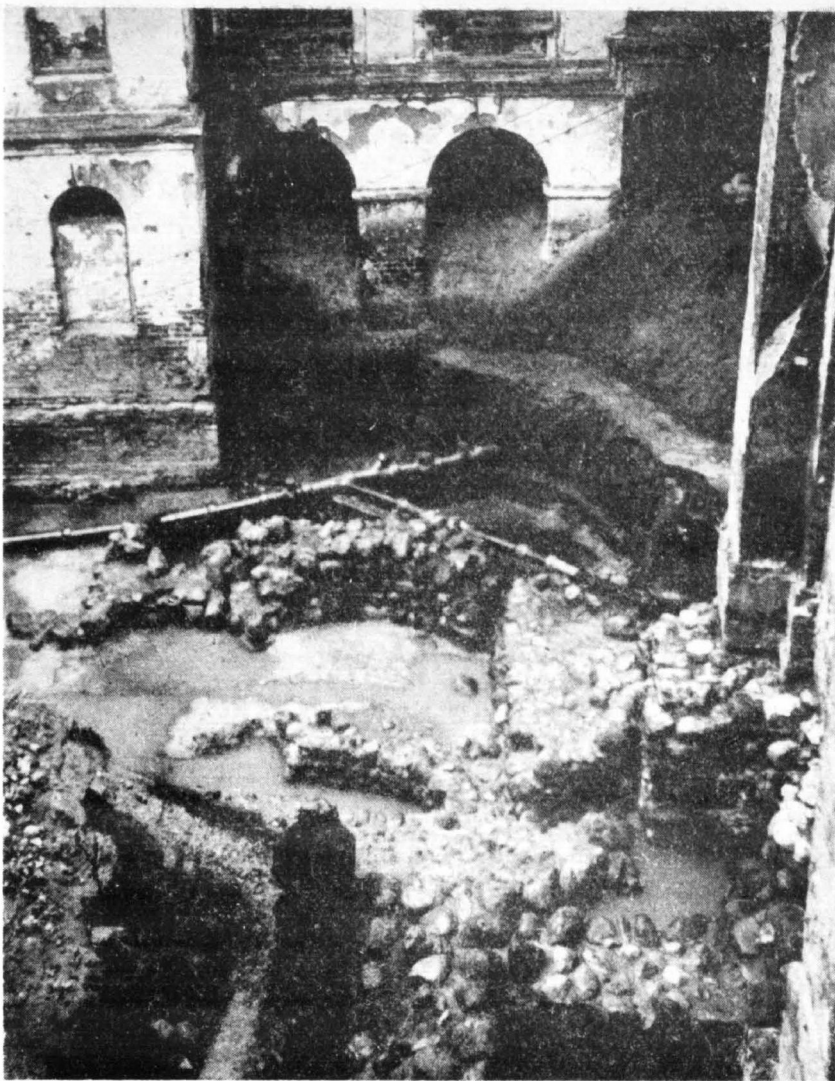
Ryc. 3. Fragment fundamentów kamiennych XI-wiecznego monasteru benedyktyńskiego odkrytych w roku 1963 na podwórze przy ul. Tumskiej 2 między wieziami Zegarową i Szlachecką
