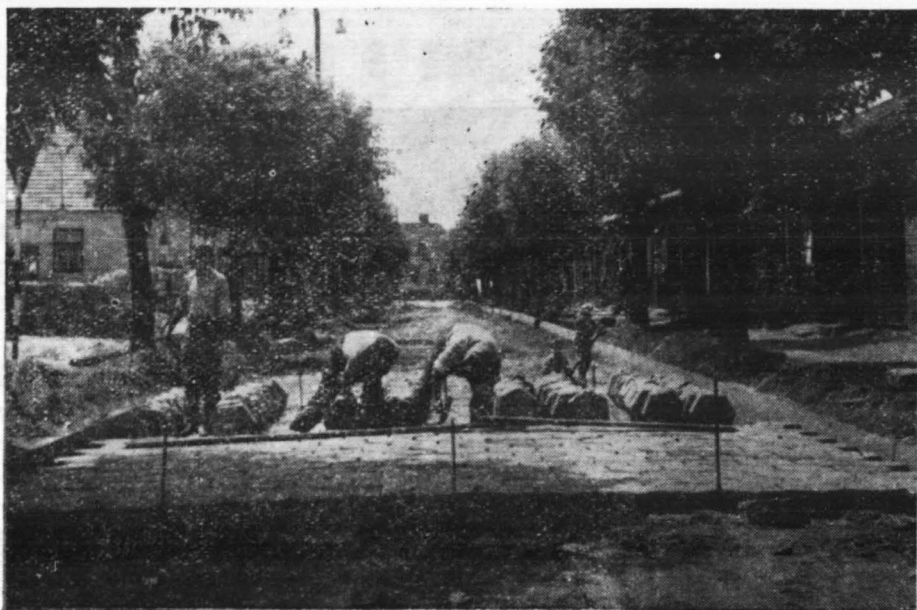
Miejska Służba Drogowa zmienia nawierzchnię ul. S. Okrzei z brukowej na ulepszoną. W 1964 r. 43,1% płockich ulic posiadało nawierzchnię ulepszoną (w 1938 — 12%, a w 1960 r. — 21,0%), 24,3% nieulepszoną (bruki i tłuczeń, a 32,6% nieurządzoną (służbową i gruntową).
