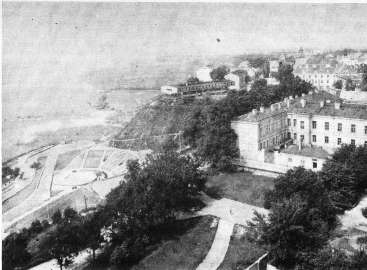
Unikalnie położony amfiteatr, wykonany w czynie społecznym przy dotacji państwa. Do połowy maja 1969 r. Płockie Przedsiębiorstwo Robót Mostowych zakończy budowę ciągów pieszych i schodów — wyjść na promenadę na skarpie.
