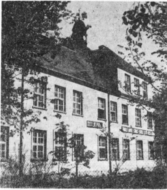
Budynek szkolny, w którym w roku szkolnym 1945/46 znalazła pomieszczenie Szkoła Podstawowa nr 1
