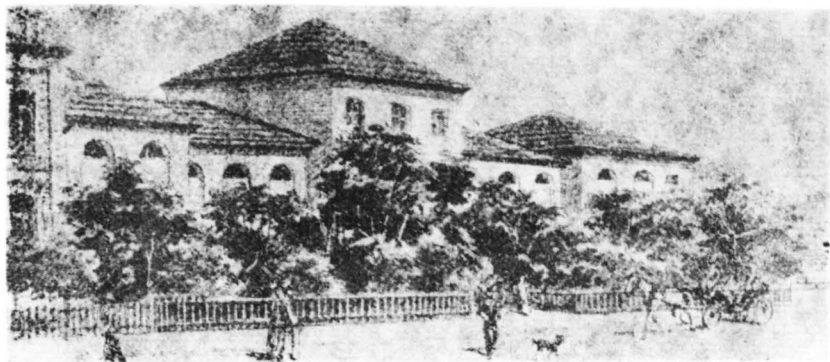
Budynek Arsenалу przy ulicy Długiej w Warszawie. Tu w latach 1646–1648 Kazimierz Siemienowicz był czynny jako inżynier i zastępca dowódcy artylerii polskiej; tu obmyślał i konstruował swoje rakiety
