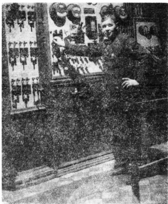
Stacja rozdzielcza prądu elektrycznego. Zdjęcie sprzed II wojny światowej.
