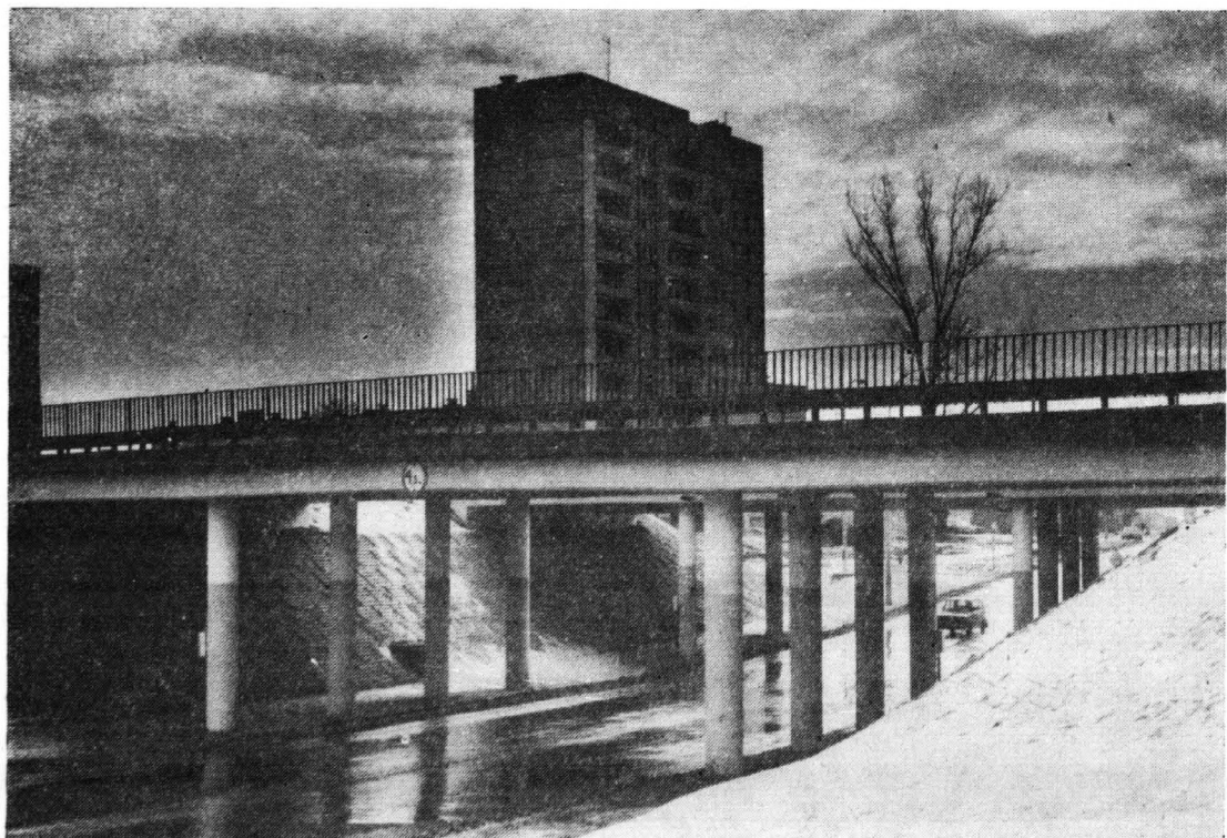
Oddany do użytku w grudniu 1987 roku wiadukt na połączeniu ulicy Szopena z ulicą Spółdzielczą.
