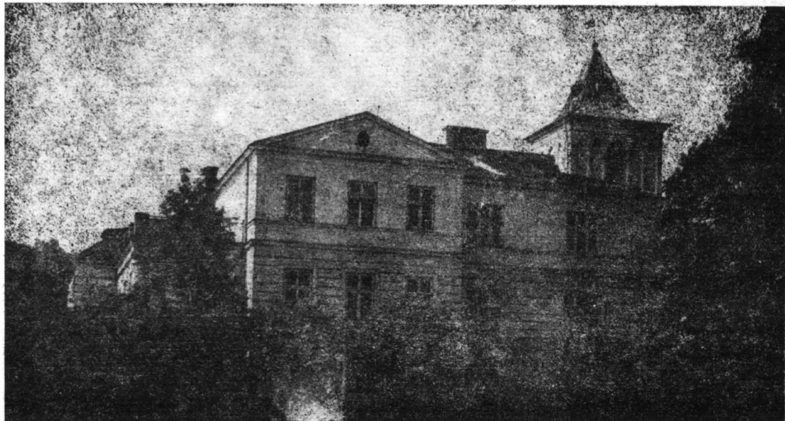
Pałac w Giżycach — Elewacja od ogrodu (sprzed przebudowy po 1915 r.)
