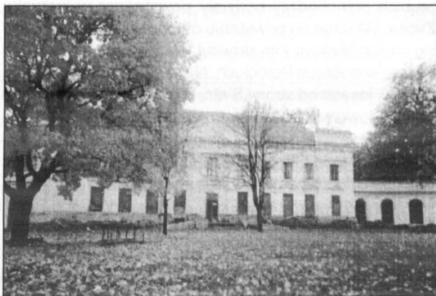
Wygląd zewnętrzny pałacu w Słubicach w czasie generalnego remontu na jesieni 2004 r.
