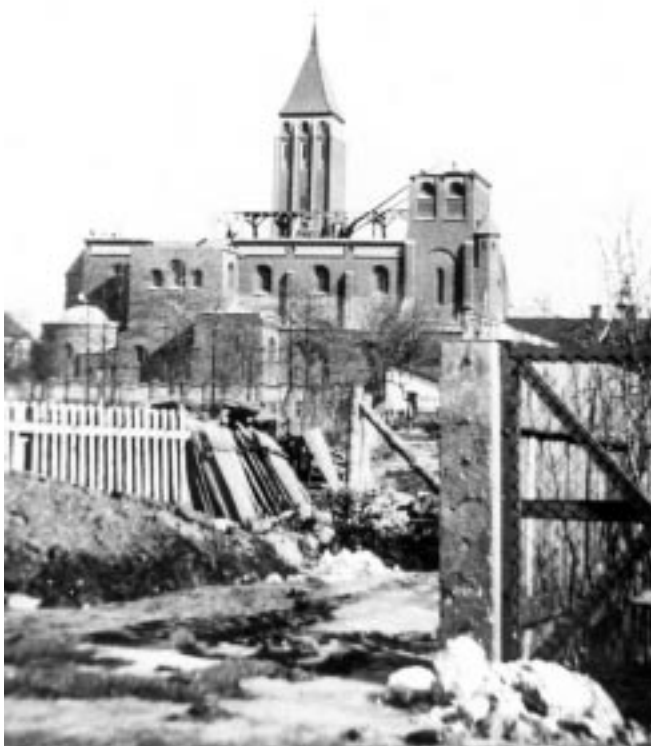
Kościół w czasie rozbiórki. Zdjęcie ze zbiorów Tadeusza Trojanowskiego
