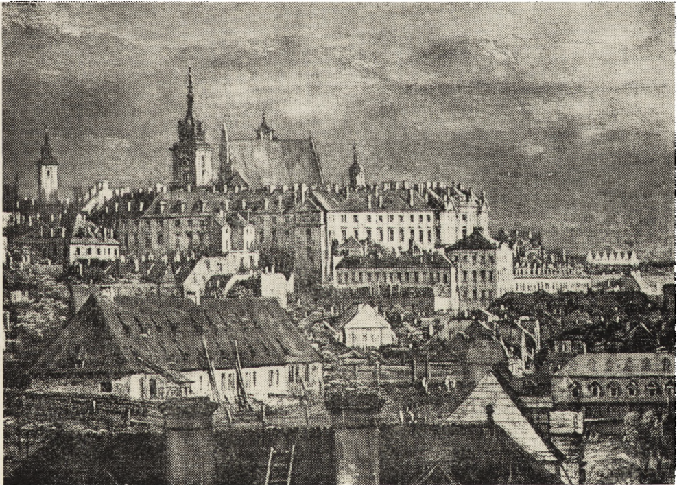
Ryc. 176. Widok Zamku Warszawskiego w końcu XVIII w. od strony południowej. Fragment z obrazu Canaletta.
