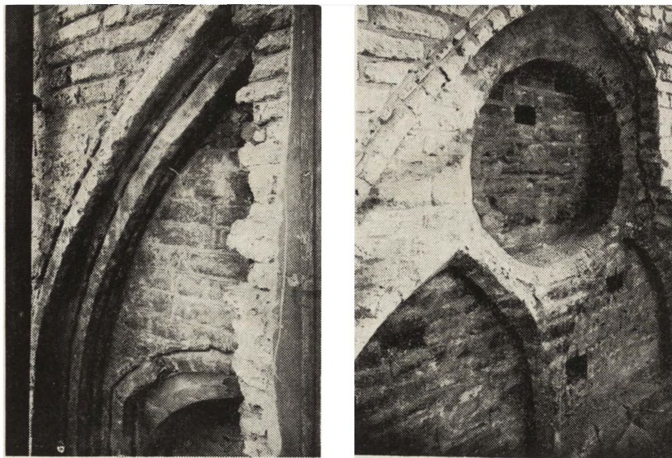
Ryc. 170 i 171. Fragmenty elewacji „Domu Dużego“ (XV w.).
