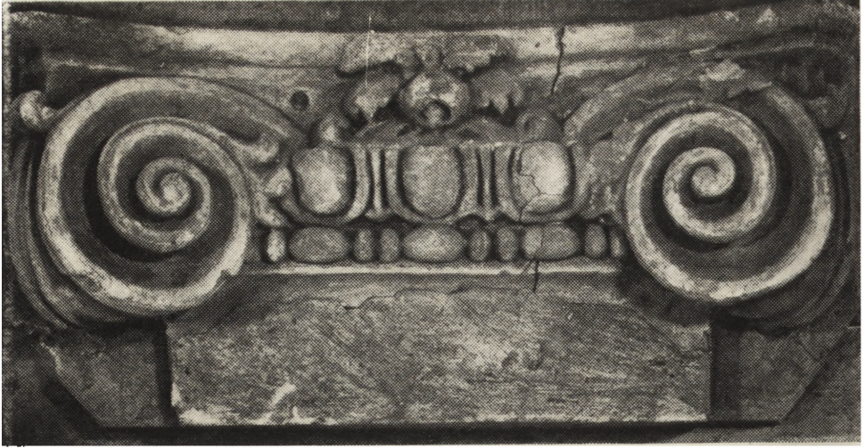
Ryc. 210. Schody wielkie. Głowica pilastru.
