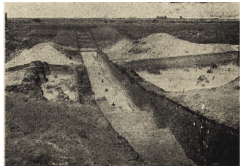
Ryc. 121. Przekop główny przez grodzisko w Bródnie Starym r. 1949.
