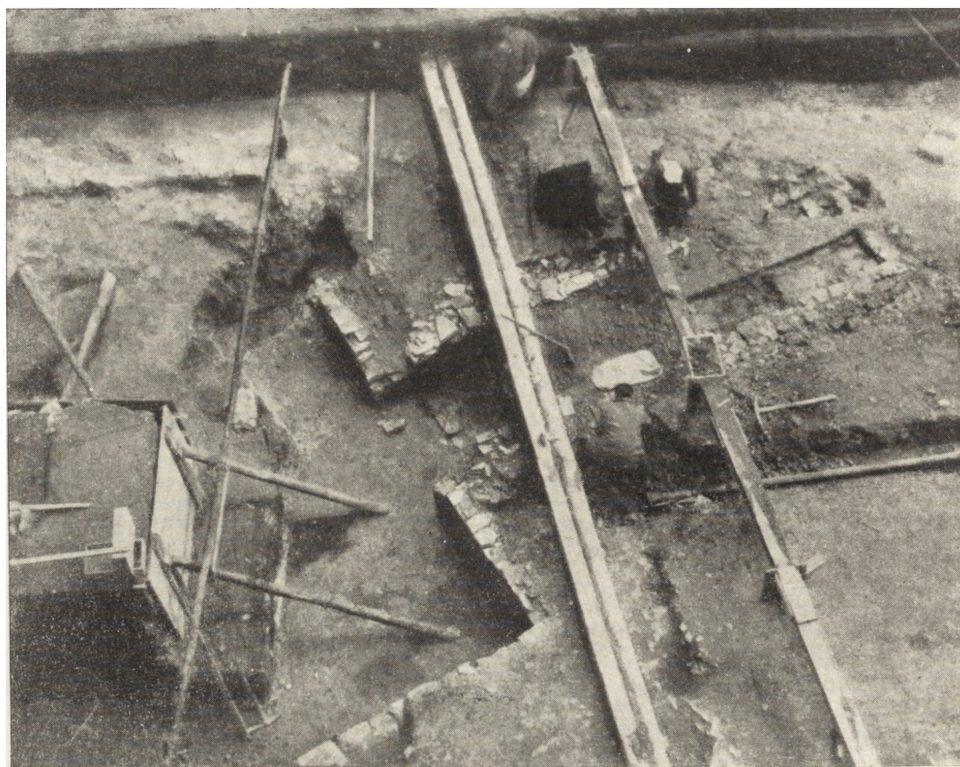
Ryc. 29 Wawel — Zarys fundamentów budowli przedromańskiej w trakcie badań. Fot. Zaki.
