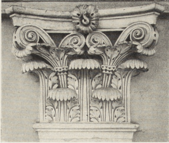
Ryc. 69. Głowica pilastra uzupełniona w około 60% (prawa strona) przez rzeźbiarza Fr. Zimnego w/g usuniętego osypującego się fragmentu. fol. Kozłowska
