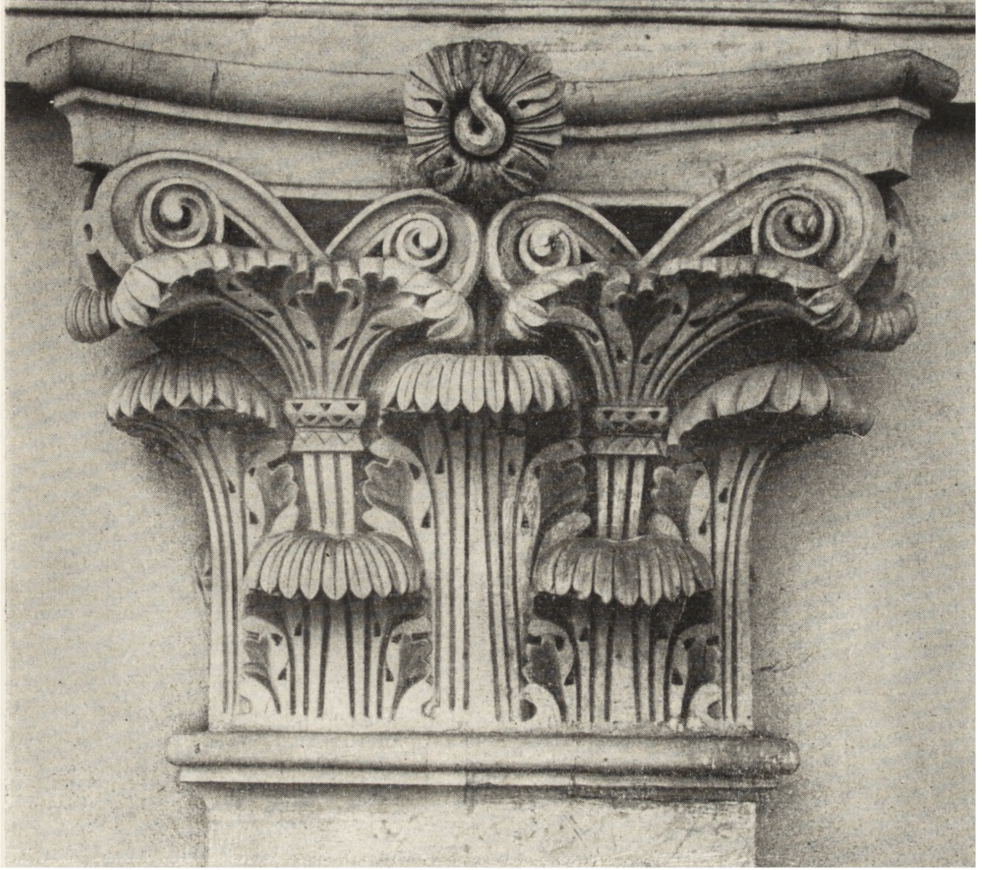
Ryc. 68. Głowica pilastra uzupełniona w około 60%.
