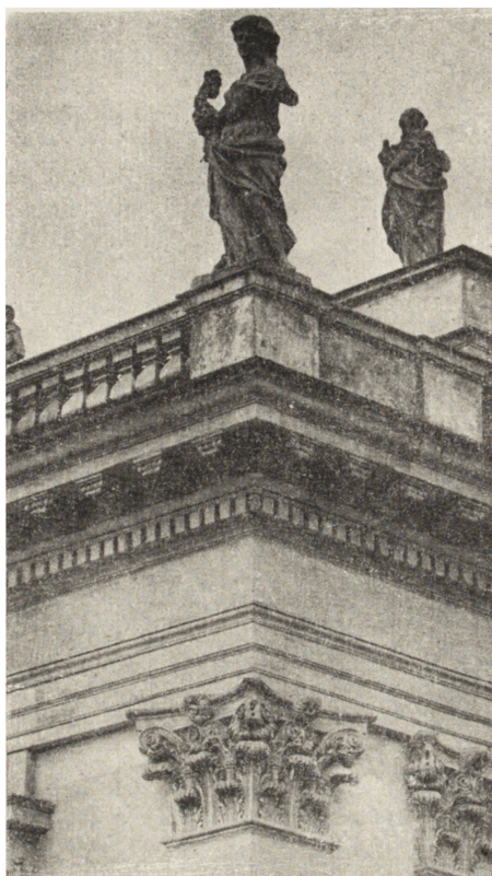
Ryc. 73. Prawidłowo skomponowany narożnik południowo-wschodni elewacji południowej.
