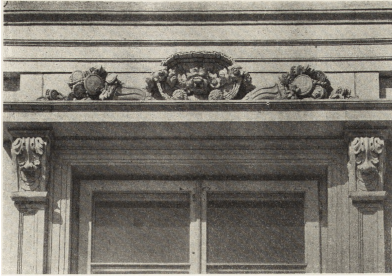
Ryc. 66. Obramienie drzwi balkonu prawego ryzalitu zrekonstruowane wg lewego zachowanego. Konsole do połowy autentyczne.
