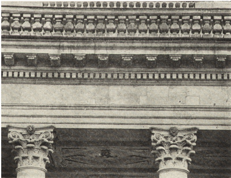
Ryc. 75. Portyk południowy. Nowe piaskowcowe głowice i architraw. Gzyms z balustradą uzupełniony w 30%. fol. Kozłowska
