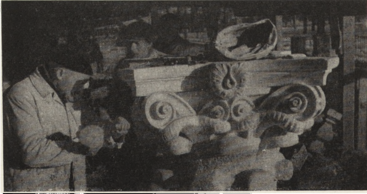
Ryc. 76. Obróbka głowic korynckich dla portyku południowego.
