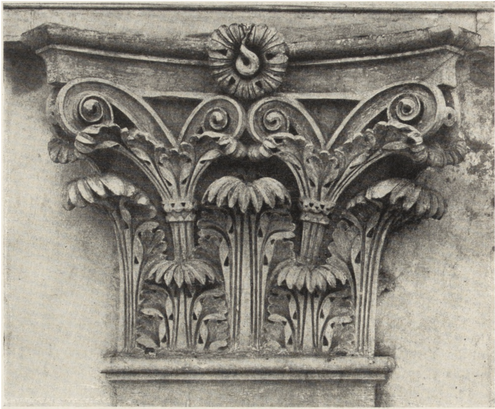
Ryc. 67. Głowica pilastra uzupełniona w około 50%.
