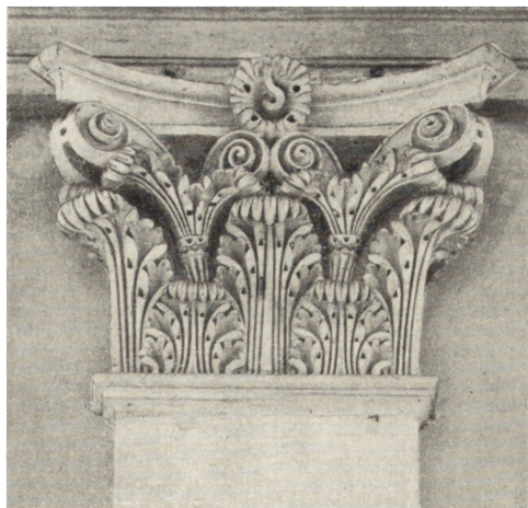
Ryc. 71. Głowica pilastra elewacji wschodniej uzupełniona w 70%. fol. Kozłowska
