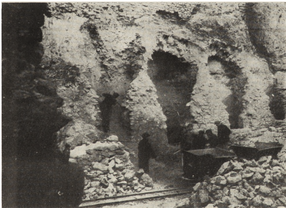
Ryc. 118. Zamek w Ogrodzieńcu. Prace nad odgruzowaniem dziedzińca arkadowego. Stan z września 1949 r.
