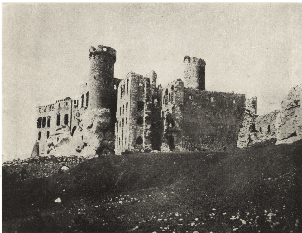
Ryc. 112. Ruiny zamku w Ogrodzieńcu. Widok od strony północnej. Stan z roku 1914. Ze zb. B. I. Z.
