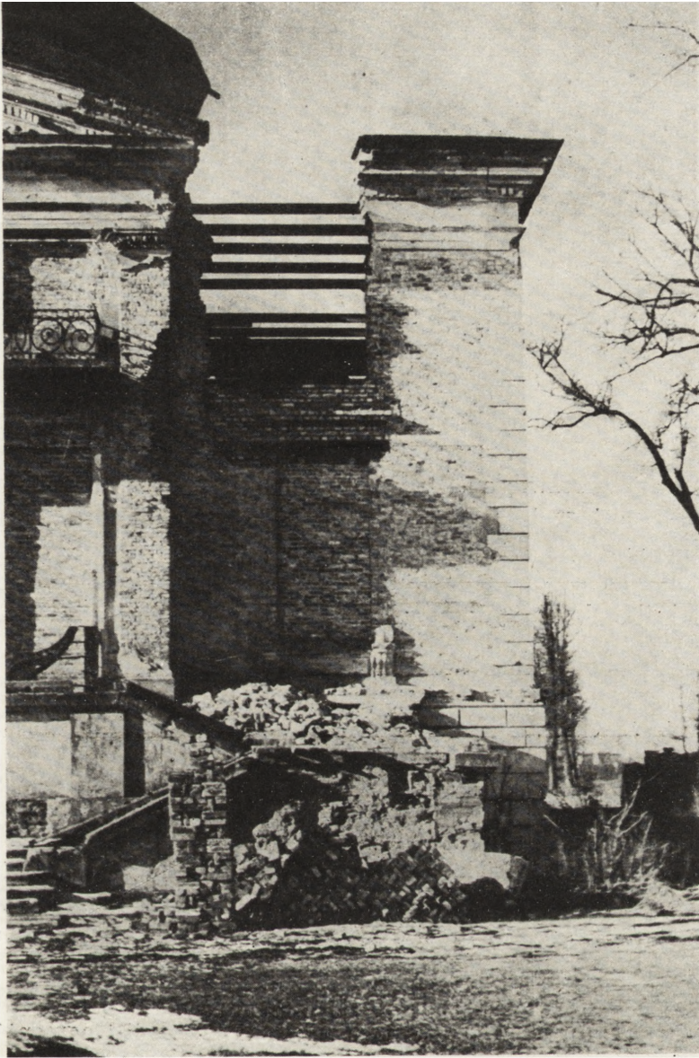
Ryc. 152. Warszawa — odbudowa pałacu w Królikarni. Roboty przy narożniku północno-wschodnim. Stan z r. 1946.
