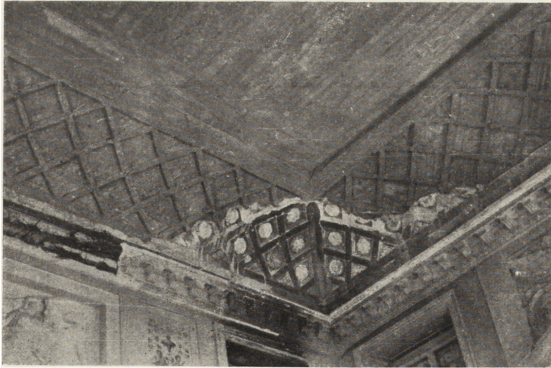
Ryc. 151. Warszawa — Łazienki Królewskie — zrekonstruowane w żelbecie sklepienie lustrzane Sali Balowej w Pałacu na Wodzie. Stan z r. 1946.
