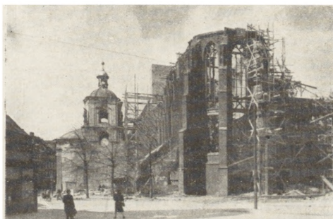
Ryc. 177. Wrocław — kość. św. Wincentego od strony wschodniej. Ze zb. U. K. Wrocl.
