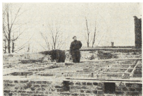
Ryc. 63. Siemkowiec, pow. wieluński — dwór obronny. Montowanie stropu żelbetowego w 1951 r.
