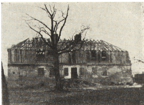
Ryc. 62. Dzierlin, pow. sieradzki — dwór w czasie prac konserwatorskich. Stan z 1951 r.
