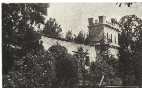
Ryc. 64. Siemkowiec, pow. wieluński — dwór obronny przed rozpoczęciem odbudowy.
