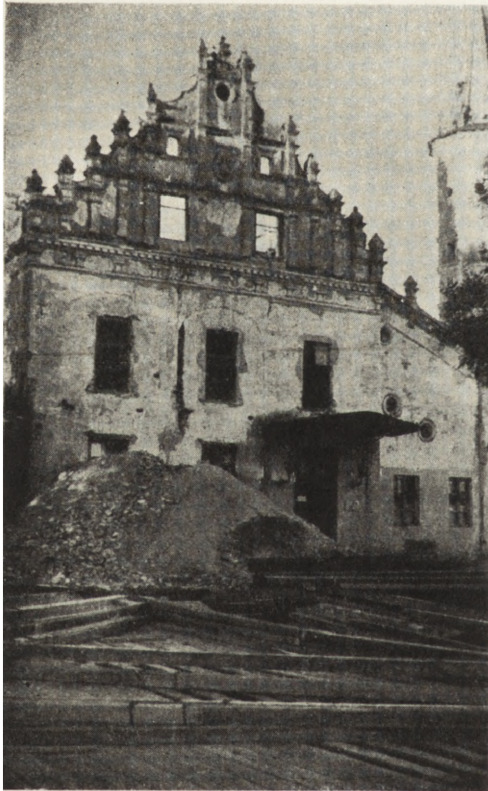
Ryc. 61. Poddębice, pow. łęczycki — odbudowa zamku renesansowego w 1951 r.
