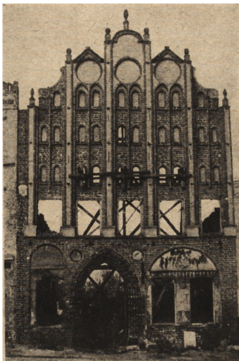
Ryc. 212. Fasada kamienicy gotyckiej przy ul. Młyńskiej w Stargardzie. Stan z r. 1952.
