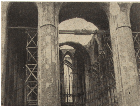
Ryc. 206. Prezbiterium kośc. św. Jakuba w Szczecinie w trakcie odbudowy.
