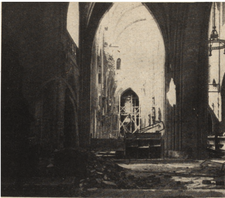
Ryc. 285. Wnętrze południowej nawy bocznej — widok ku zachodowi. Stan z r. 1947.
