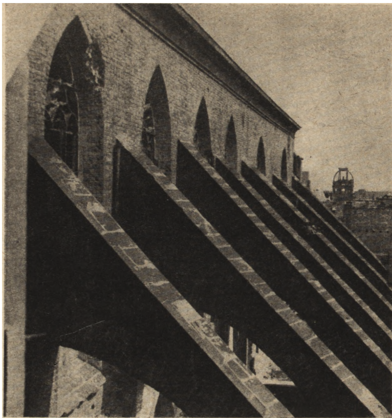
Ryc. 274. Łęki odporne ściany południowej nawy głównej — widok ku wschodowi. Stan z r. 1949.
