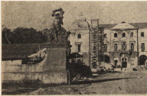
Ryc. 312. Białystok — część fasady pałacu podczas prac konserwatorskich w r. 1950.
