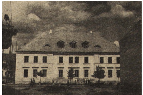
Ryc. 315. Białystok — Loża Masońska. Stan podczas prac konserwatorskich w r. 1951.
