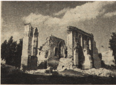
Ryc. 318. Wizna, pow. łódzki — kościół halowy z XVI w. Stan podczas prac konserwatorskich w r. 1950.
