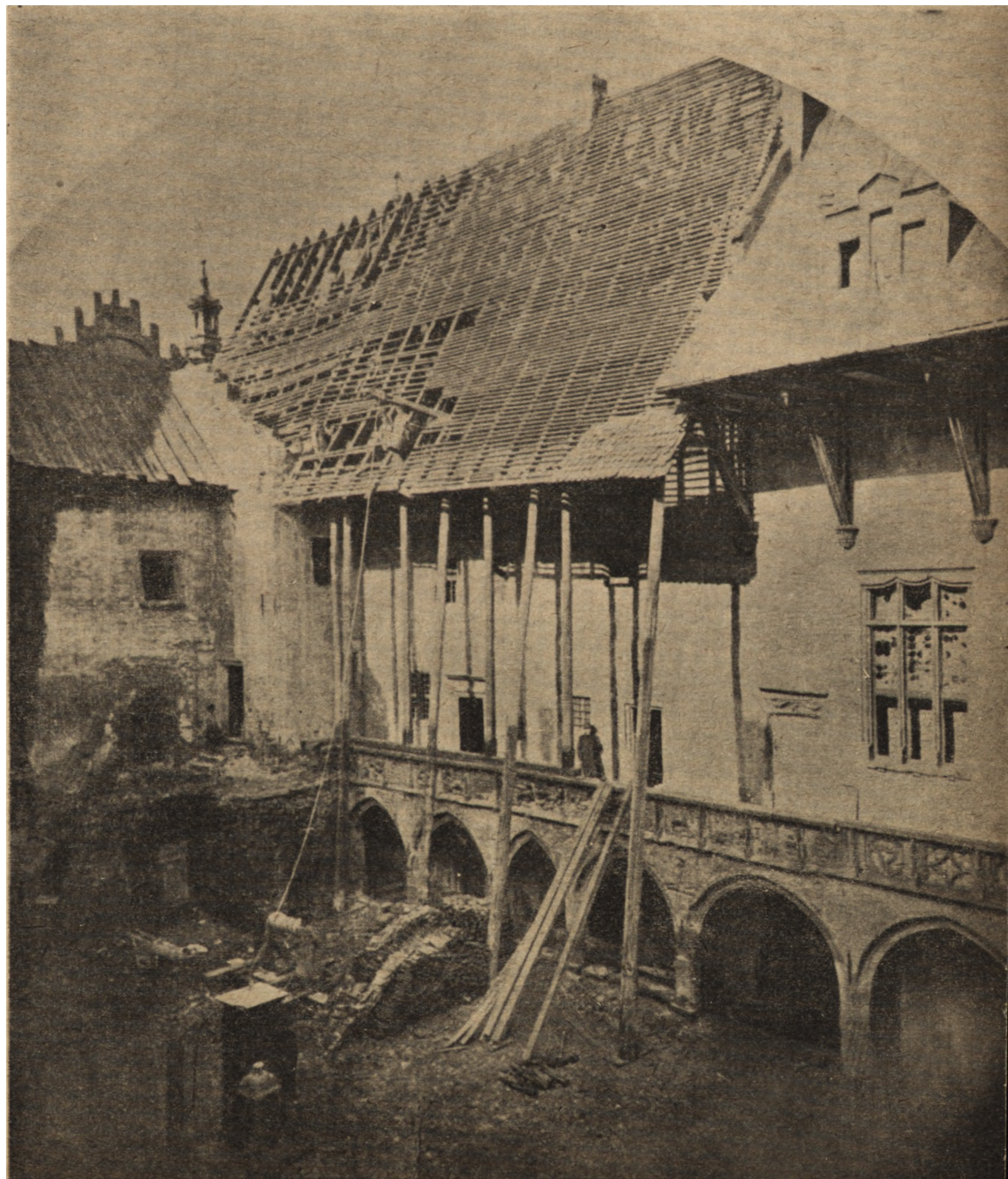
Ryc. 12. Burzenie starych dachów oraz nowe dachy w północnym narożniku Collegium Maius. Fotografia ok. r. 1870.
