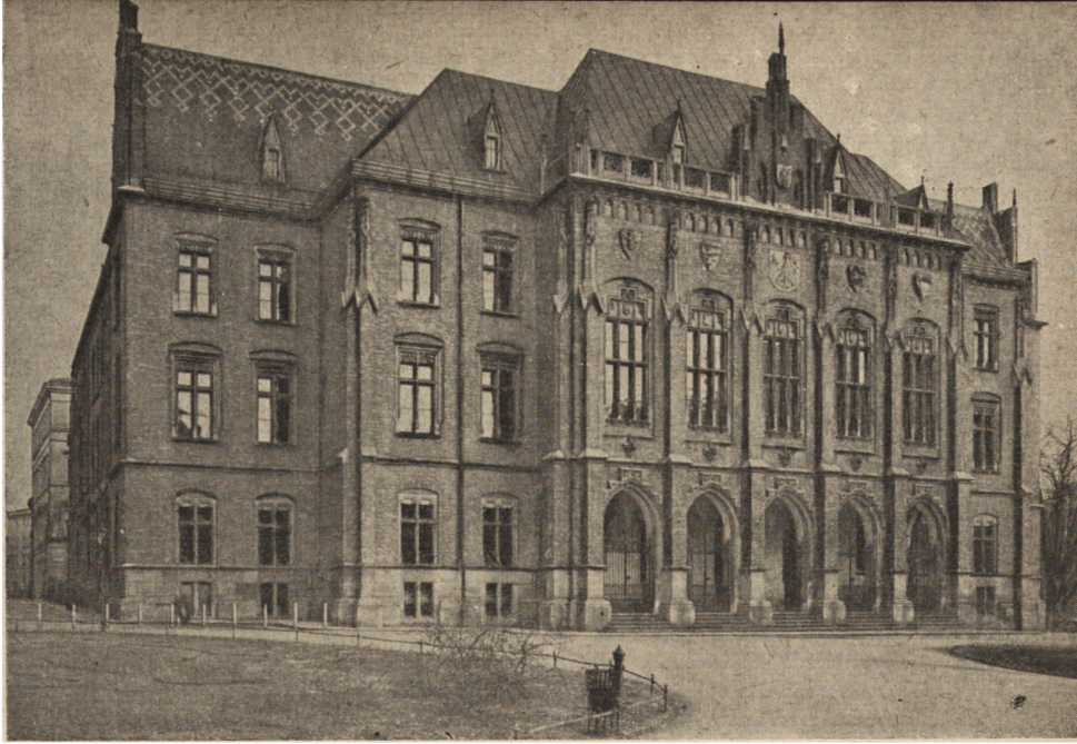
Ryc. 14. Collegium Novum w Krakowie. Budowa F. Księżarskiego z r. 1883—87.
