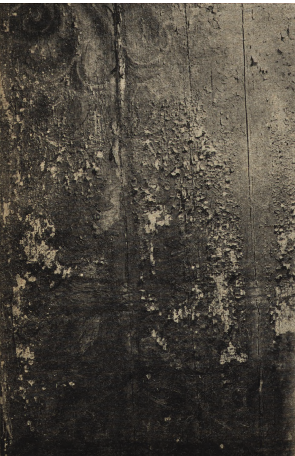
Ryc. 164. Fragment łuszczącego się malowidła w kamienicy Szlichtingów na II p. Przed konserwacją.
