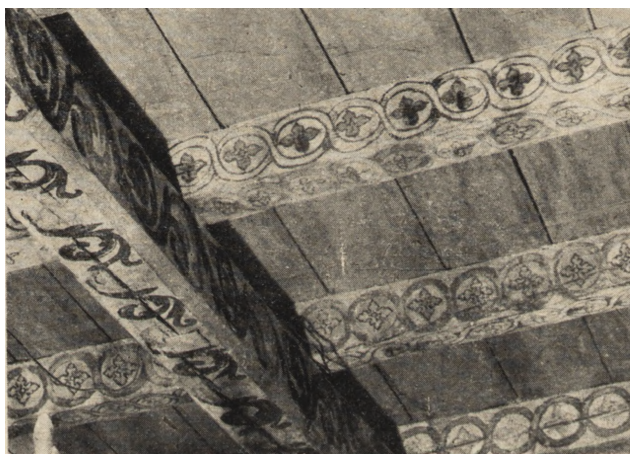
Ryc. 162. Fragment stropu w kamienicy na Krak. Przedmieściu nr 3. Po konserwacji.
