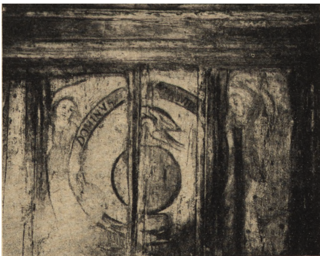
Ryc. 169. Fragment polichromii stropu drewnianego izby I p. w kamicnicy w Rynku St. Miasta nr 34. Stan po konserwacji w maju 1952.
