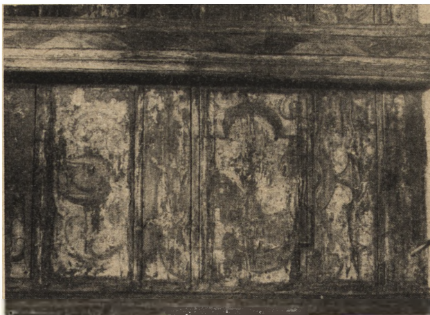
Ryc. 168. Fragment stropu w kamicnicy Schlichtingów na I p. po zabezpieczeniu i oczyszczeniu.
