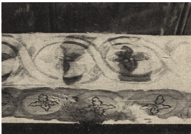
Ryc. 161. Fragment stropu na Krak. Przedmieściu nr 3. Widoczne ciemne zacieki. Przed konserwacją.
