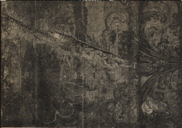
Ryc. 163. Fragment polichromii stropu II p. kamienicy Szlichtingów (Rynek St. Miasta 34). Widoczne zniszczenia drewna przez odłamki bomby lotniczej. Przed konserwacją.
