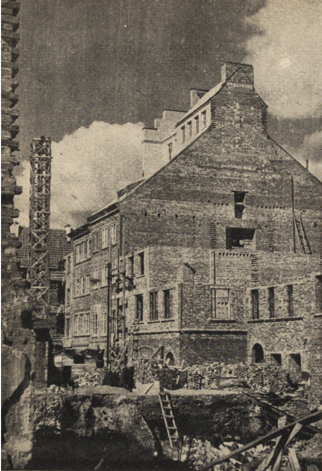
Ryc. 197. Odbudowa St. Miasta. Fragment ul. Piwnej w r. 1951.
