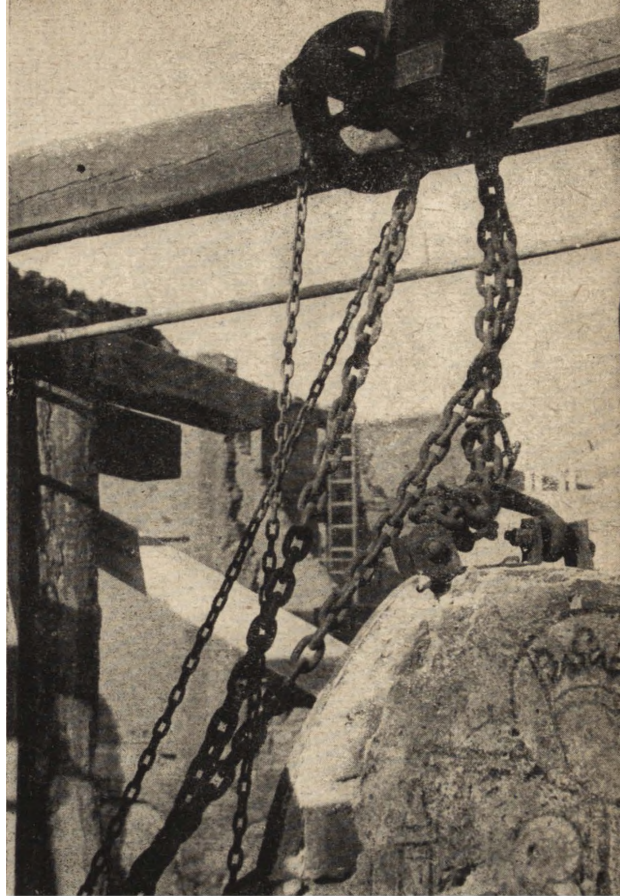
Ryc. 219. Blok i zaczepa.
