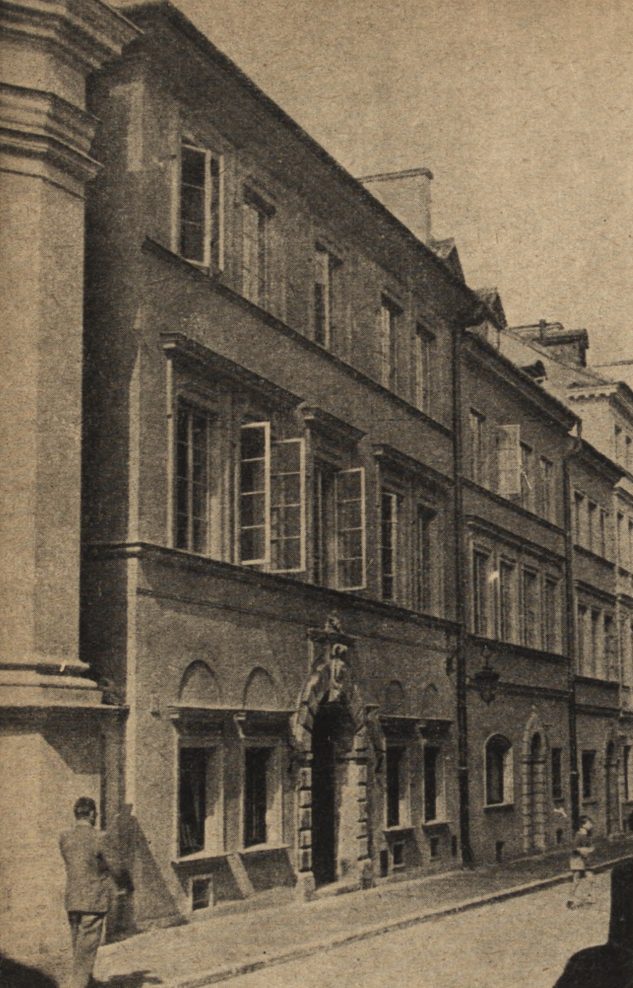
Ryc. 221. Kamienica przy ul. Piwnej 13. Dawny szpital św. Ducha po odbudowie.
