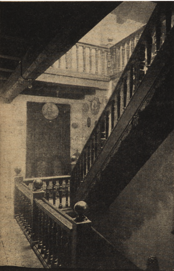
Ryc. 223. Klatka schodowa w kamienicy Baryczków przed spaleniem.
