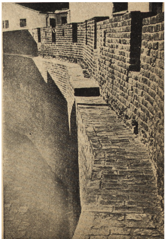
Ryc. 119. Chodnik na murach obronnych w części rekonstruowanej w r. 1938.
