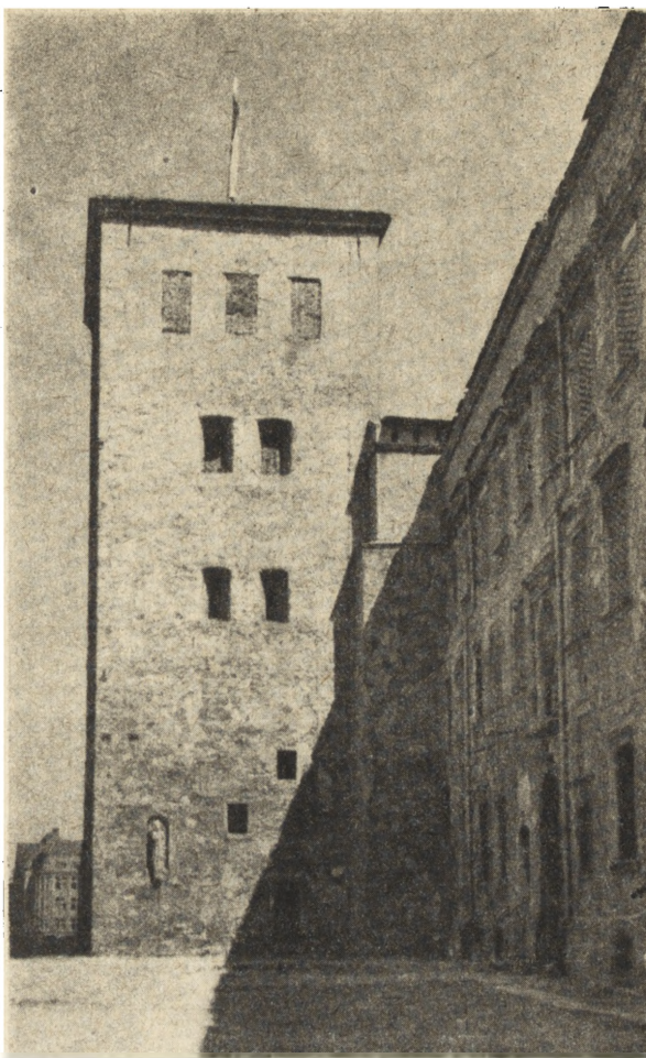
Ryc. 235 Szczecin — zamek, widok wieży kaplicznej od strony dziedzińca menniczego.
