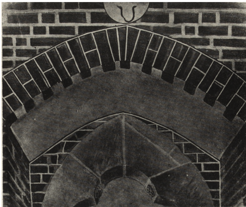
Ryc. 17. Rudy kościół pocysterski — widok nadproża portalu głównego-zachodniego od wewnątrz kościoła. Spoiny cegieł łuku niszy malowane czarno-biało-czarno na tle wzmocnionej czerwieni cegieł; podniebienie niszy szaro-niebieskie, podłęczne zwężenia ścianki nad kamiennym nadprożem — imitacja spoin na zaczerwienionym tle. Stan 1947. Dziś nie istnieje.
