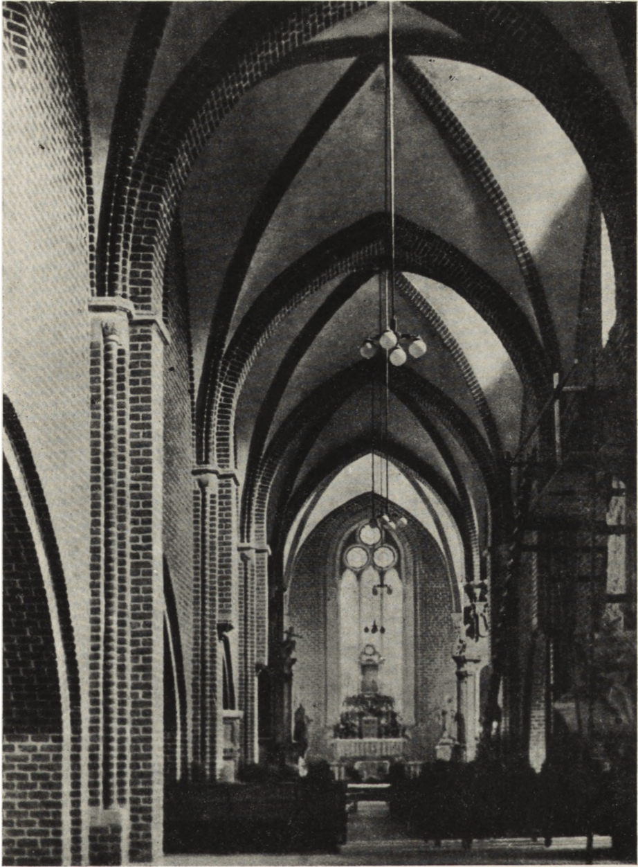
Ryc. 18. Rudy, kościół pocysterski. Widok wnętrza po rekonstrukcji — całkowitym odsłonięciu najstarszego wątku, regotycyzacji okien naw, odsłonięciu i rekonstrukcji okna i maswerku w ścianie wschodniej prezbiterium.
