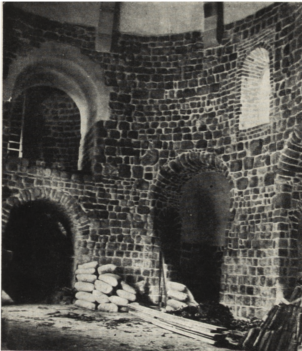
Ryc. 20. Strzelno, rotunda św. Prokopa, wewnątrz podczas rekonstrukcji — widok na empore wieży i absydę boczną.
