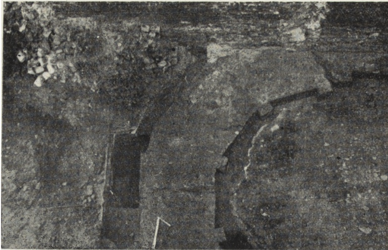
Ryc. 100. Głogów — kolegiata. Odkopane fundamenty absydy z I poł. XIII w.
