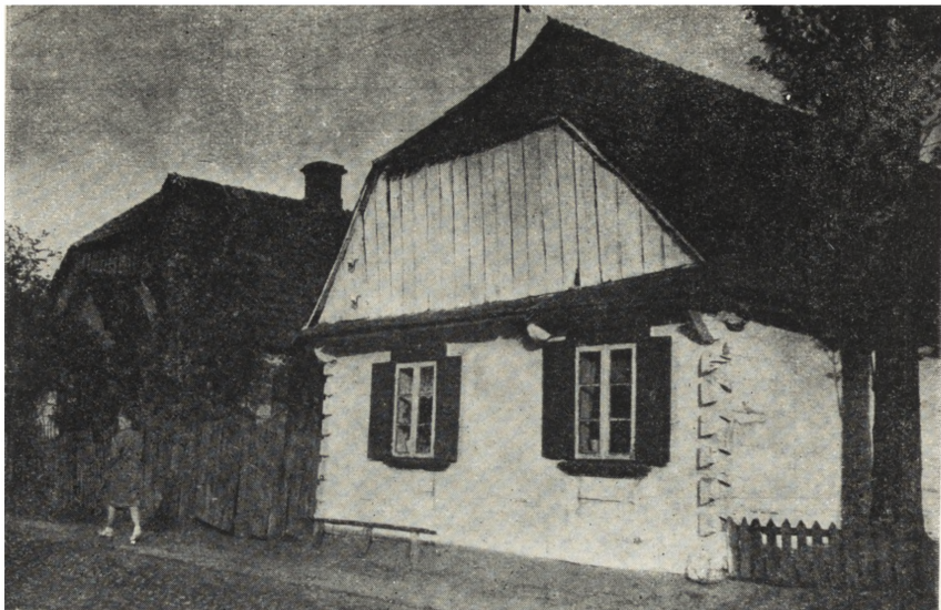
Ryc. 87. Ceglów, dom przy Rynku pod nr 9.
