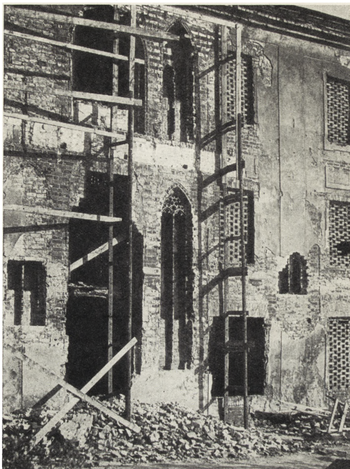
Ryc. 22. Odkrywanie elementów gotyckich na elewacji zachodniej ratusza.
