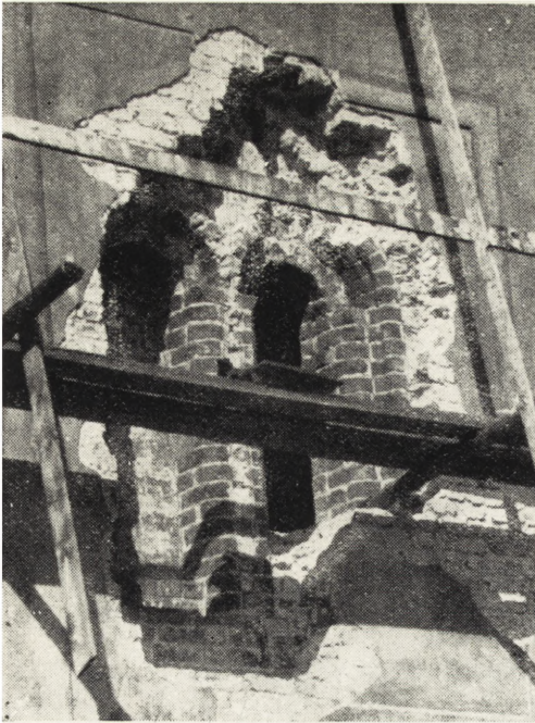
Ryc. 28. Odślonięte okno II kondygnacji na ścianie wschodniej.
