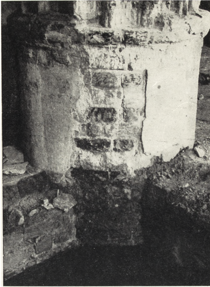
Ryc. 37. Odkrywanie filara piwnicy ratusza.
