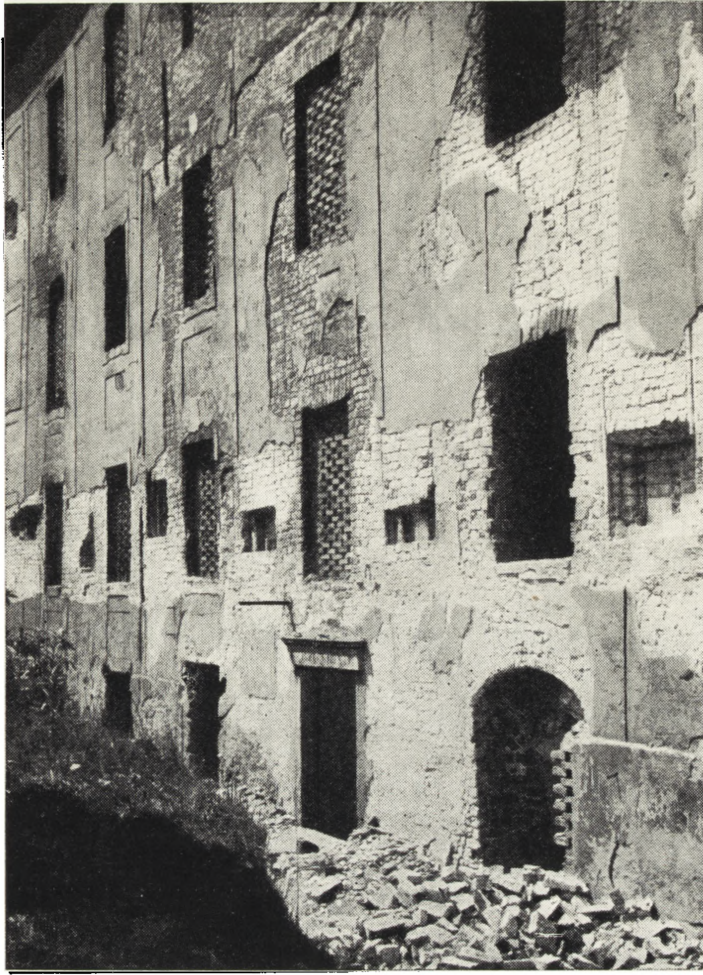
Ryc. 30. Sondowanie elementów gotyckich na ścianie wschodniej.
