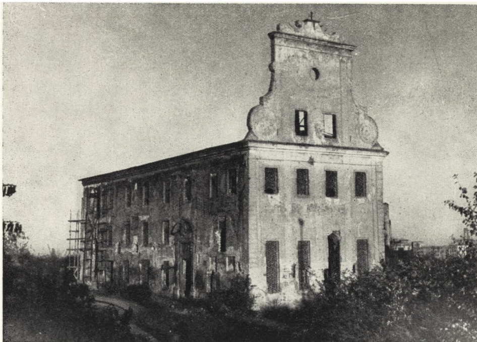
Ryc. 18. Stan obecny ratusza po zabezpieczeniach.
