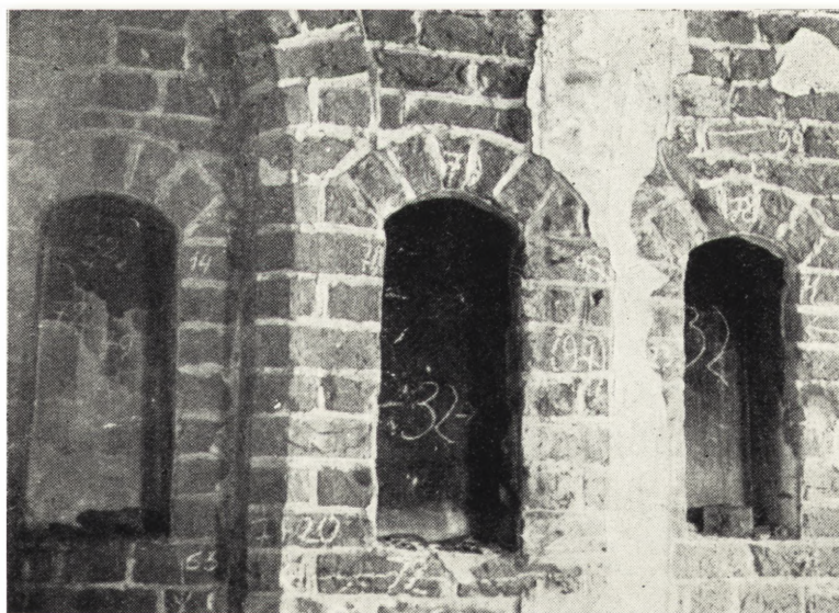
Ryc. 35. Nisza na wewnętrznej ścianie II kondygnacji.
