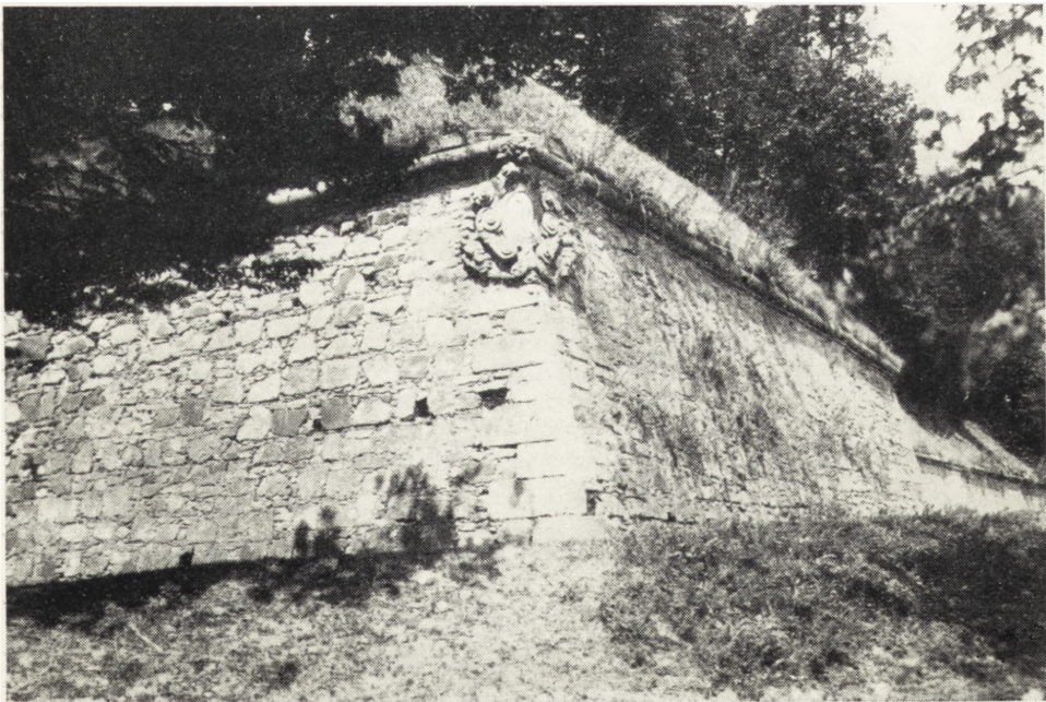
Ryc. 9. Bastion południowo-wschodni zamku w Wiśniczu.
