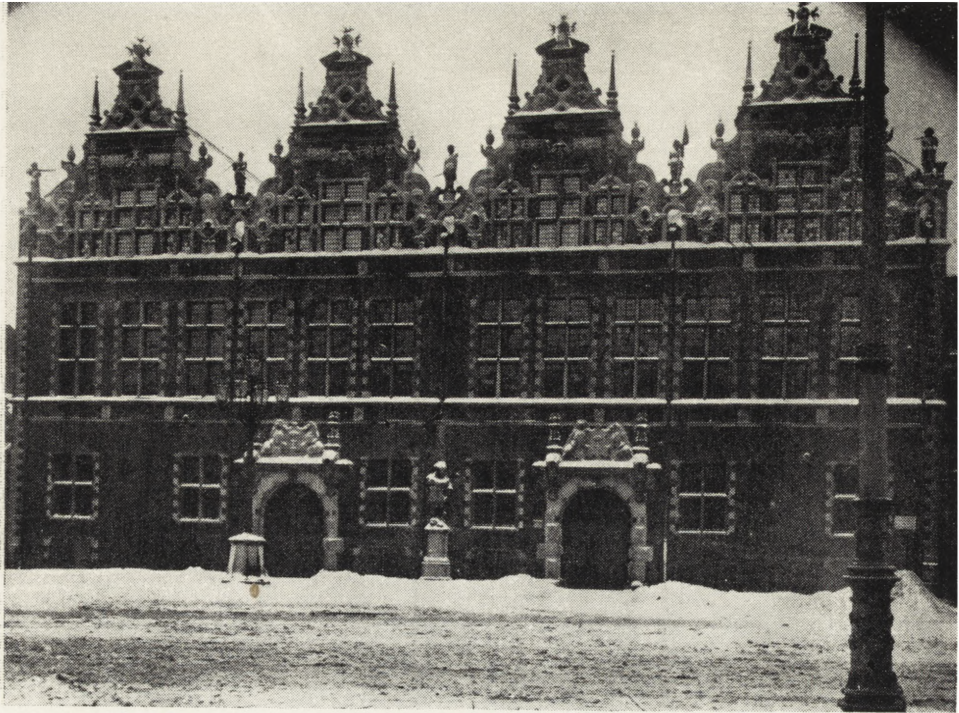
Ryc. 15. Gdańsk — Zbrojownia. Stan z r. 1912.
