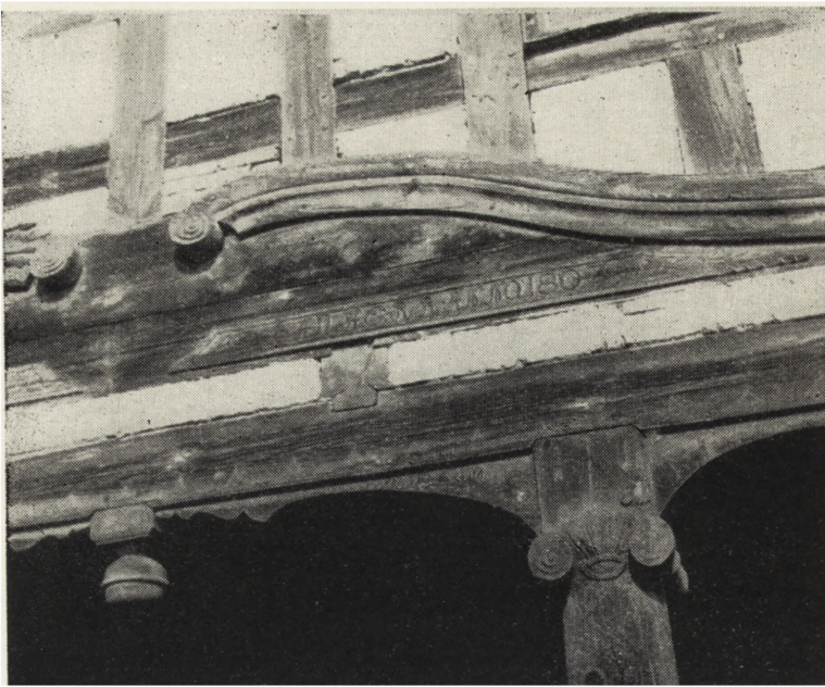
Ryc. 92. Belkowanie podcienia domu PGR Orłowo.
