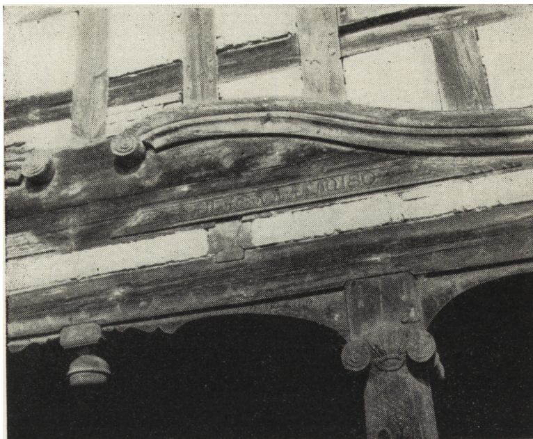
Ryc. 91. Belkowanie podcienia domu nr 31 w Orłowie.
