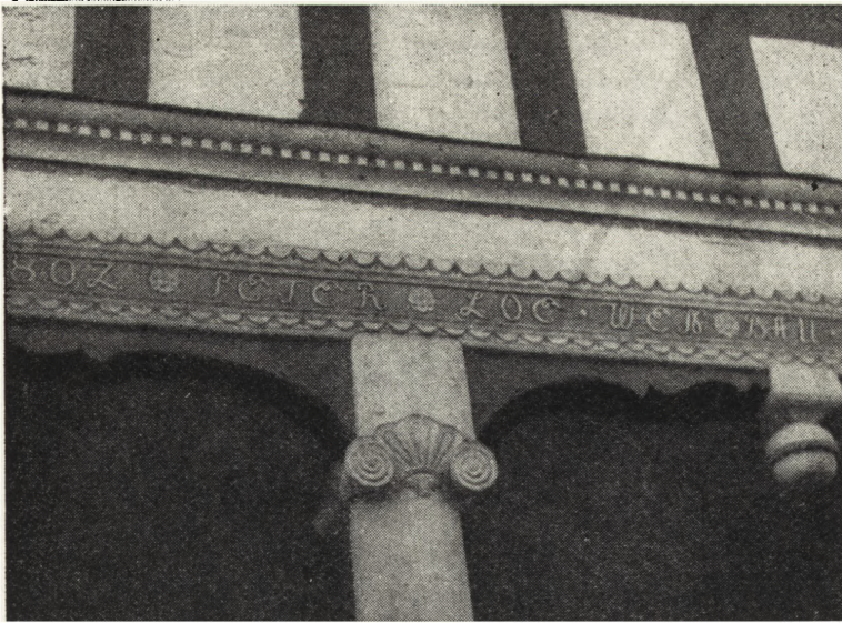
Ryc. 93. Belkowanie podcienia domu nr 68 w Żuławkach.
