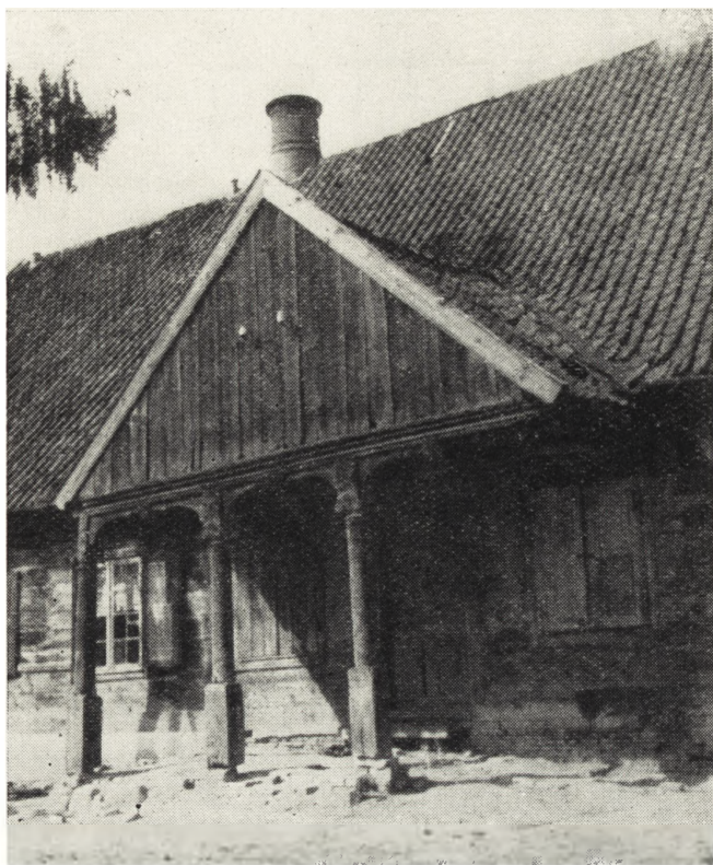
Ryc. 86. Podcien kuchenny domu nr 55 w Marynowach. Daszek wspierają tylko dwa słupki, trzeci wisi w powietrzu, czwartego brak.
