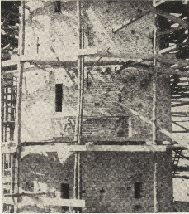
Ryc. 192. Latarnia — dawny wątek murowy: u dołu gotycki z XV w. wyżej renesansowy z II poł. XVI w. Stan w maju 1956 r.
