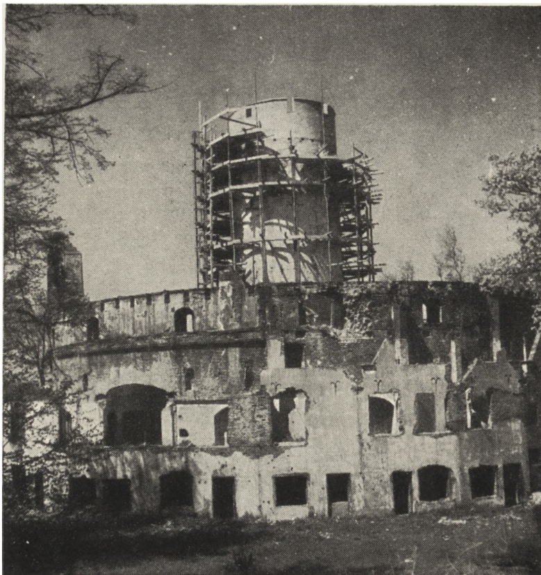
Ryc. 189. Latarnia i Wieniec. Stan w maju 1956 r.
