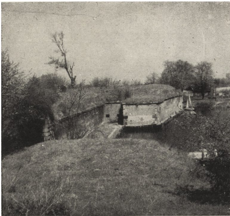
Ryc. 186. Fort carré. Widok z bastionu Południowo-Wschodniego na Ostroróg. Stan w r. 1956.
