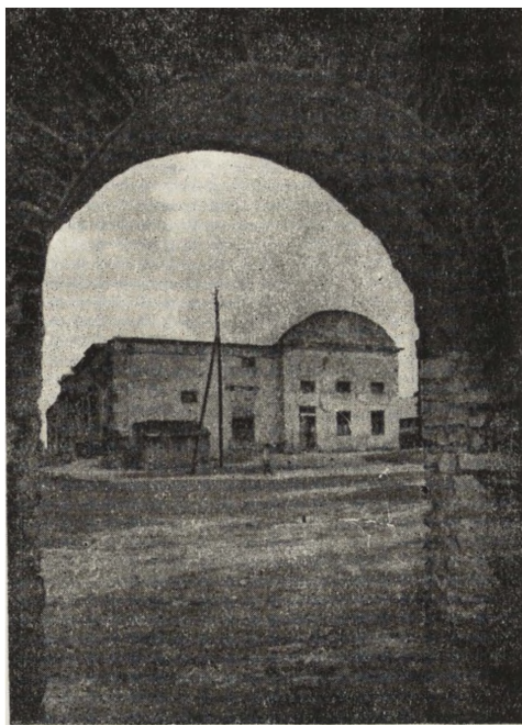
Ryc. 226. Widok z bramy zamkowej na pałac.
