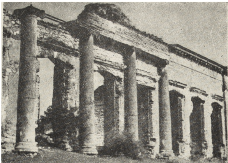
Ryc. 227. Fragment elewacji południowej pałacu.
