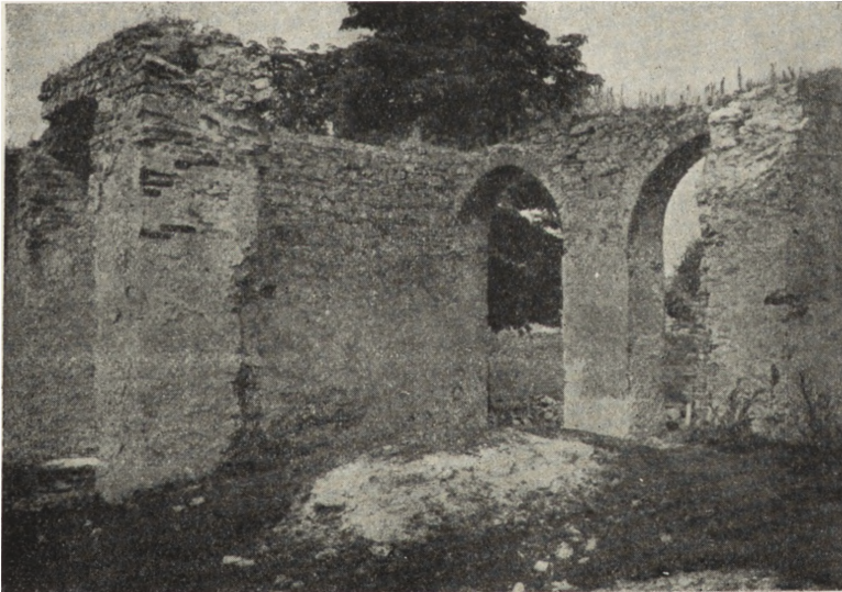
Ryc. 228. Mury wewnętrzne pałacu.
