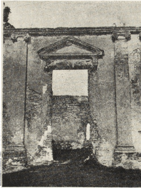
Ryc. 229. Fragment elewacji południowej pałacu.
