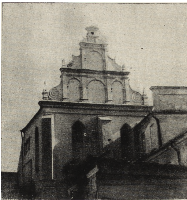
Ryc. 263. Fasada kaplicy św. Trójcy przed rozpoczęciem prac konserwatorskich.
