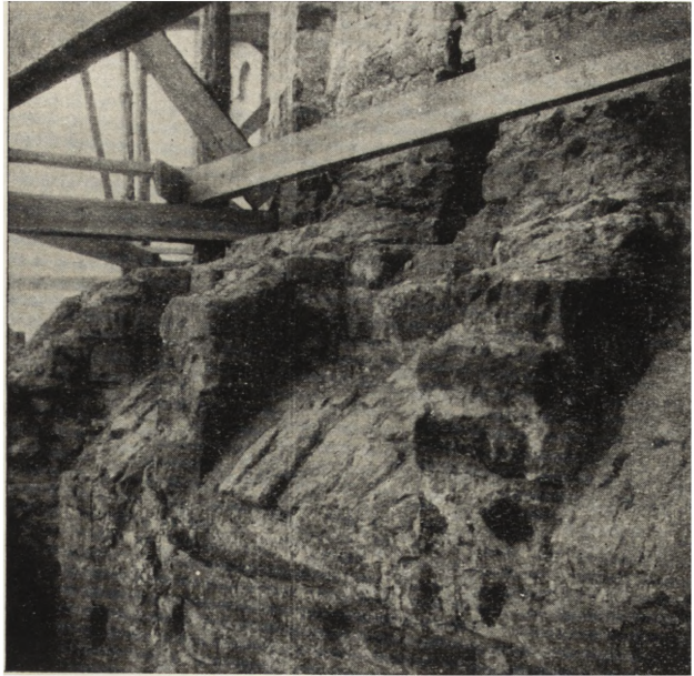
Ryc. 268. Odkryte blendy (w miejscu późniejszego gzymsu) w elewacji wschodniej absydy.
