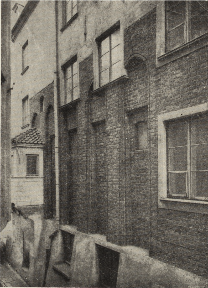
Ryc. 180. Warszawa, Rynek St. Miasta 31 — Kamienica ks. Mazowieckich. Odślonięte wnęki gotyckie. Prace TOnZP.
