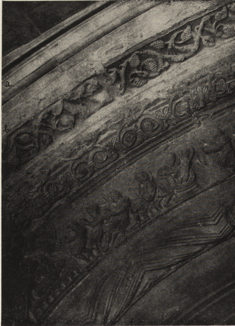
Ryc. 187. Archiwolta portalu — wycinek zachodni. Wydaje się nie ulegać wątpliwości, że fragmenty nie pochodzą z jednego czasu. Normalny postęp procesu niszczenia wydaje się we właściwym porządku uwidaczniać na pierścieniach b i c, pierścieni a i pierścieni f wydają się być całkowicie wymienione. Pierścieni b i e powymieniano częściowo.
