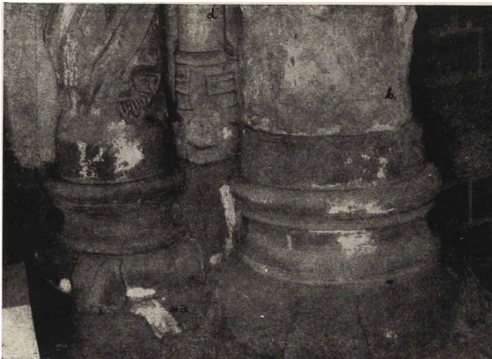
Ryc. 188. Strona wschodnia — szlifowane bazy kolumnienek (nowe), brak śladu uszkodzenia przez ścieranie lub uderzenie; a — rozpoczęte łuszczenie się droбноziarnistego białego piaskowca, b — silne łuszczenie się trzonu z kremowego średnioziarnistego piaskowca, c — oddzielająca się łuska około 15 mm gruba (obok dla skali porównawczej — moneta), d — kolumnienka — pozostałość pilastra (?).
