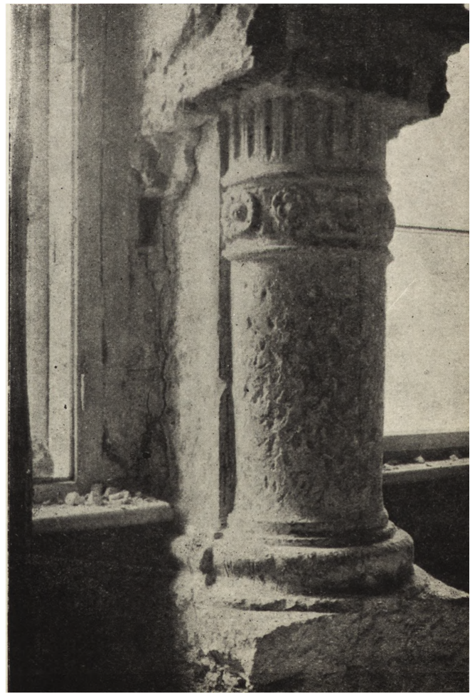
Ryc. 288. Lublin. Kamienica Sobieskich w Rynku. Dolna część kolumny odsłoniętej w filarze międzyokiennej I p.
