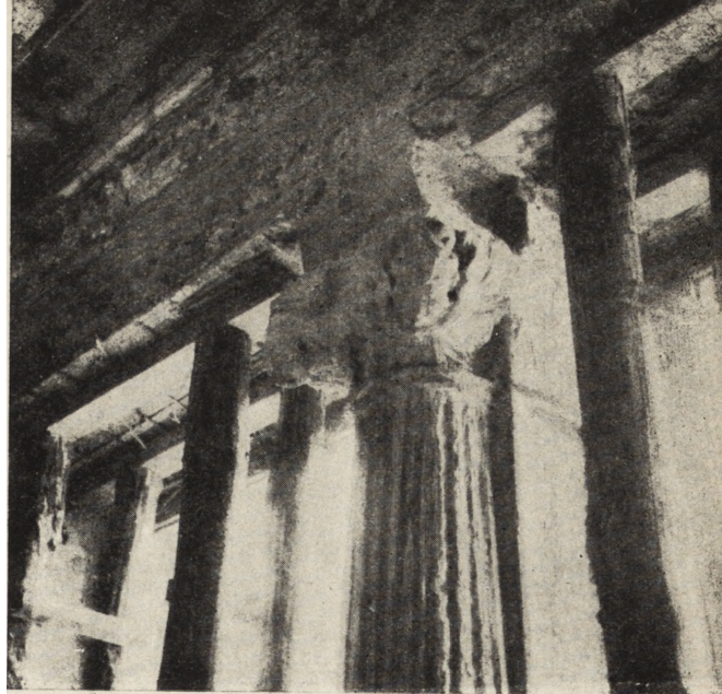
Ryc. 287. Lublin, tzw. kamienica Sobieskich w Rynku. Kapitel i górna część kolumny odsłoniętej w filarze międzyokiennej I p.
