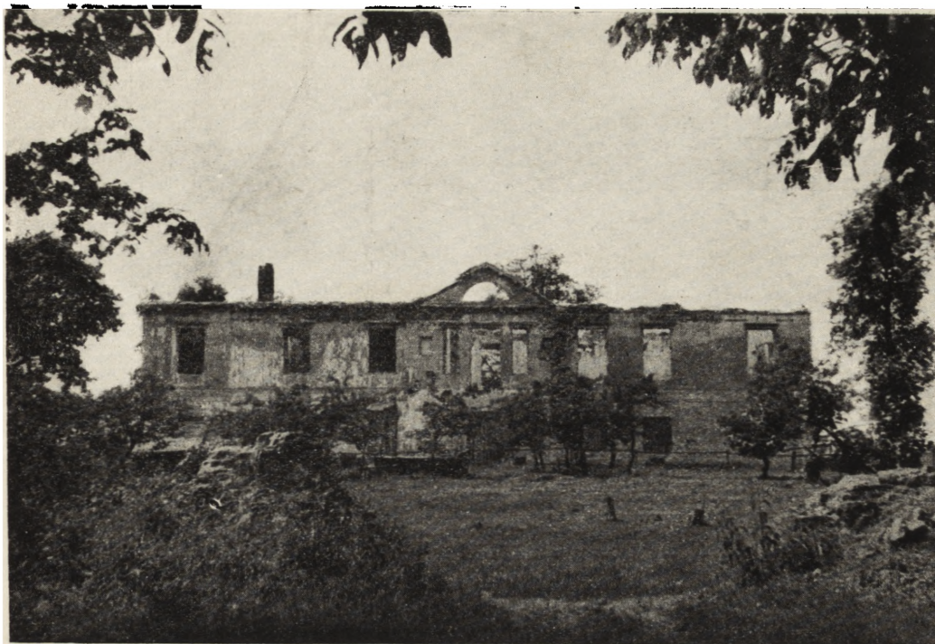
Ryc. 96. Widok dworu od frontu.
