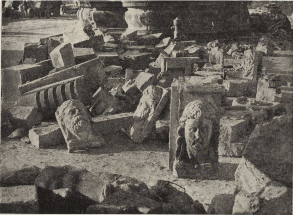
Ryc. 134. Gdańsk. Fragmenty Złotej Kamienicy — w głębi Studnia Neptuna przed odbudową.
