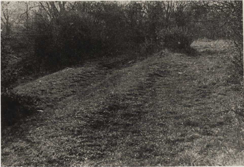
Ryc. 144. Krzepice. Kurtyna między bastionami II i III. Górna powierzchnia wału oraz uskok w połowie zewnętrznego oskarpowania.
