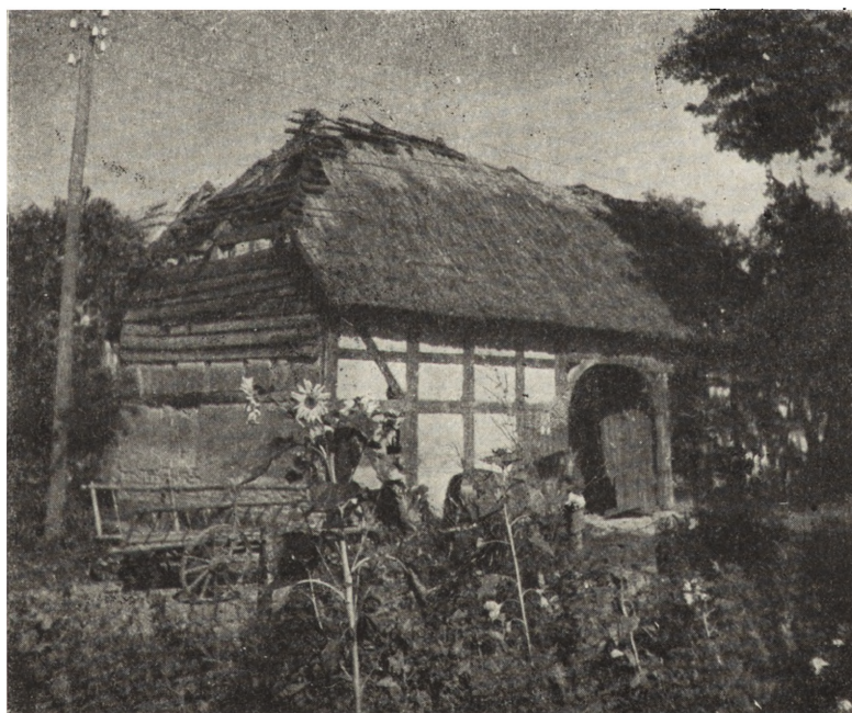
Ryc. 178. Samlino, zagroda nr 19. Budynek bramny, widok od drogi.
