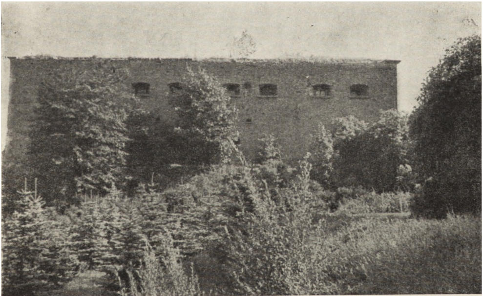
Ryc. 206. Cytadela. Działobitnia broniąca dostępu wzdłuż linii brzegowej od północy.
