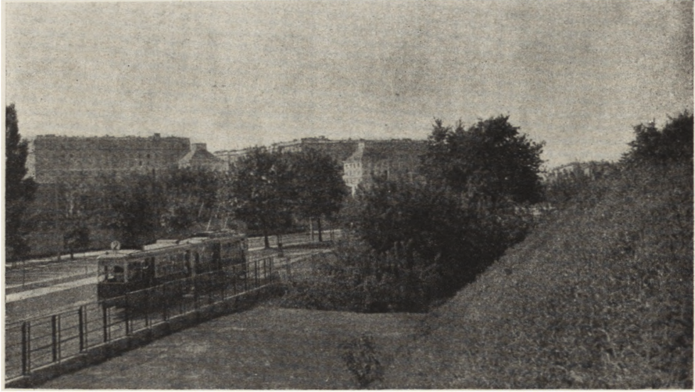
Ryc. 212. Cytadela. Fosa niepotrzebnie zasypana i kazamaty przeciwskarpy w forcie Traugutta zniszczone w czasie budowy Śródmiejskiej Trasy Obwodowej.
