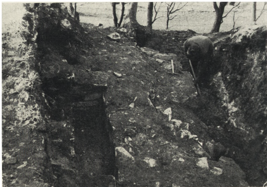
Ryc. 12. Przemyśl. pozostałości murów „palatium“ (narożnik pld.-wsch.) poza dziedzińcem, od strony wzgórza zamkowego, w trakcie odstaniania w 1960 r. (fot. autor)
